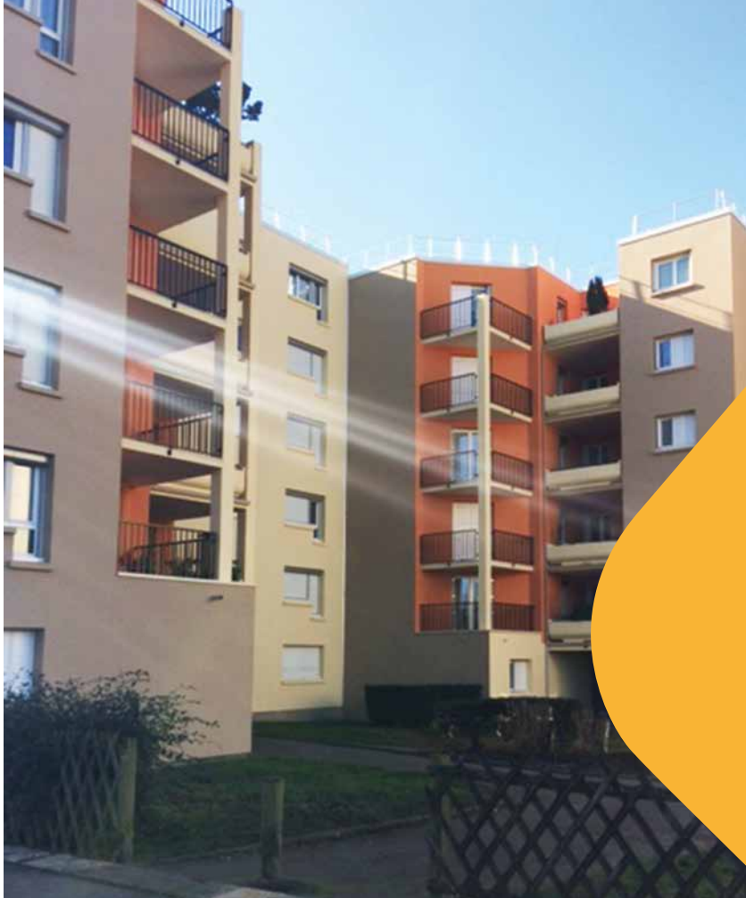
Jacques Millet / Champ de la cour : ravalement des façades de 193 logements
