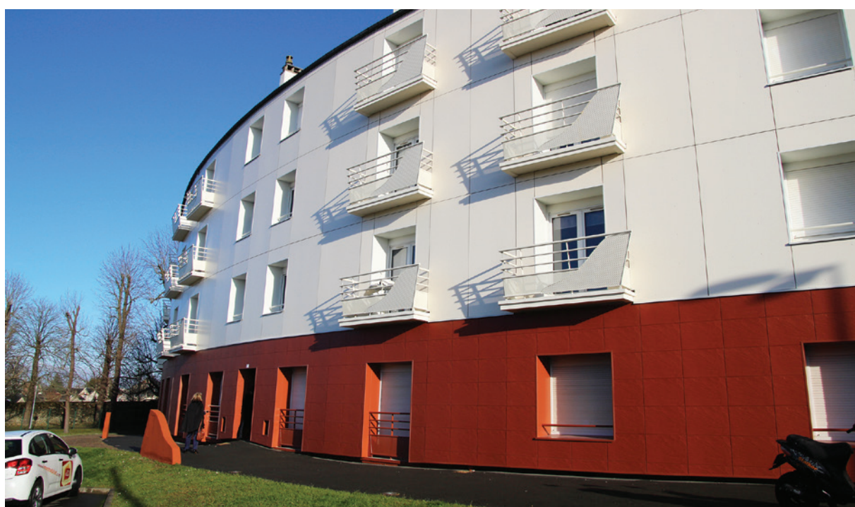
Résidence Lelièvre (33 logements) : isolation thermique par l'extérieur : 309 500 € .
