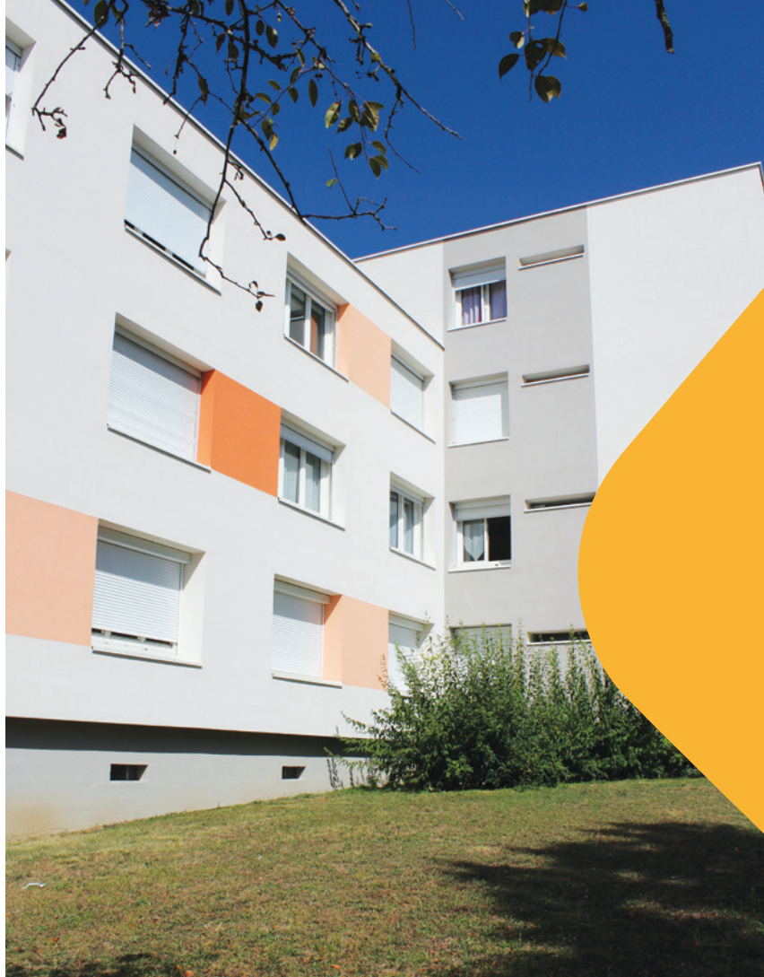
Résidence Ballon (16 logements) : isolation thermique par l'extérieur, plafond et sous-sol. Remplacement portes accès d'immeubles, réfection installation électrique des logements et parties communes et modernisation des salles de bain : 349 000 € .
