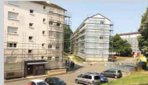
Epine isolation extérieure : 420 logements
